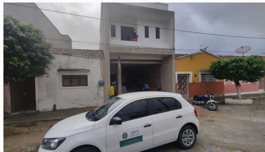
Foto 02 - Obra na cidade de ARARA
