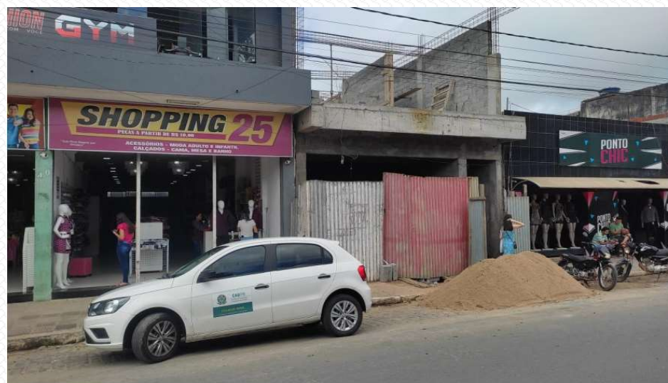
Foto 05 - Obra na cidade de SOLÂNEA
