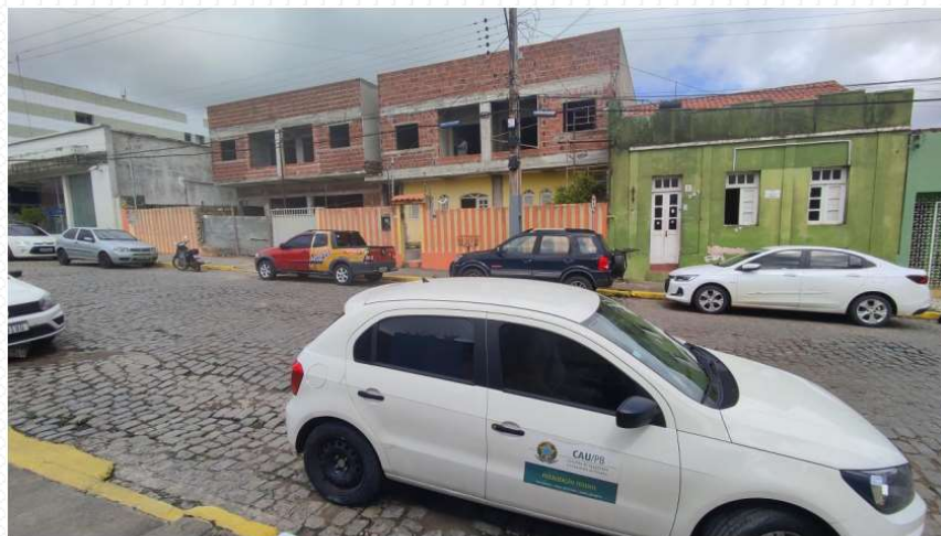
Foto 01 - Obra na cidade de AREIA
