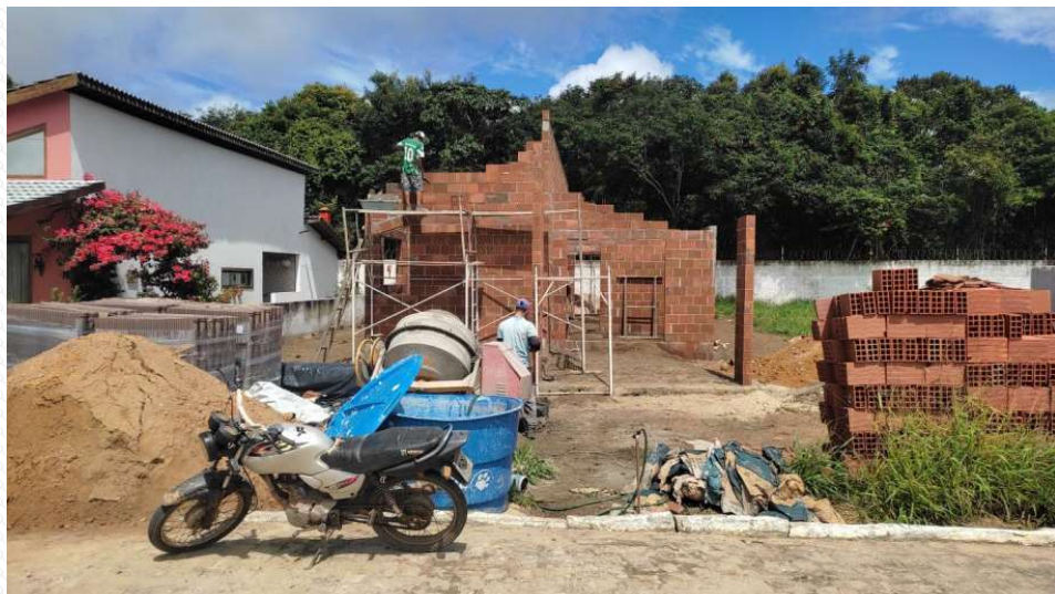
Foto 04 - Obra na cidade de BANANEIRAS
