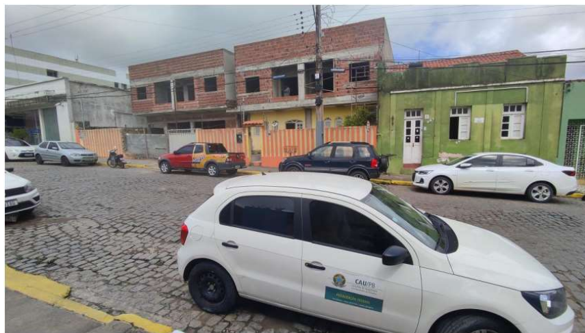
Foto 01 - Obra na cidade de AREIA
