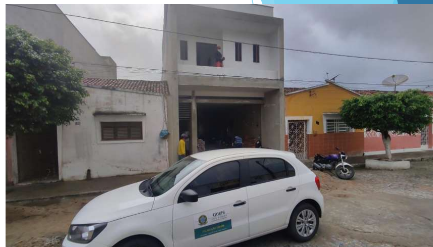
Foto 02 - Obra na cidade de ARARA
