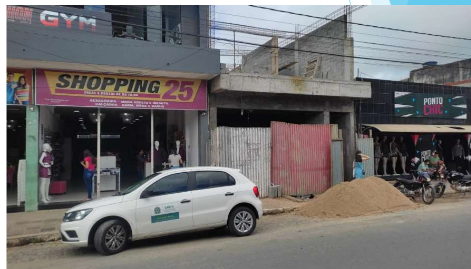
Foto 05 - Obra na cidade de SOLÂNEA
