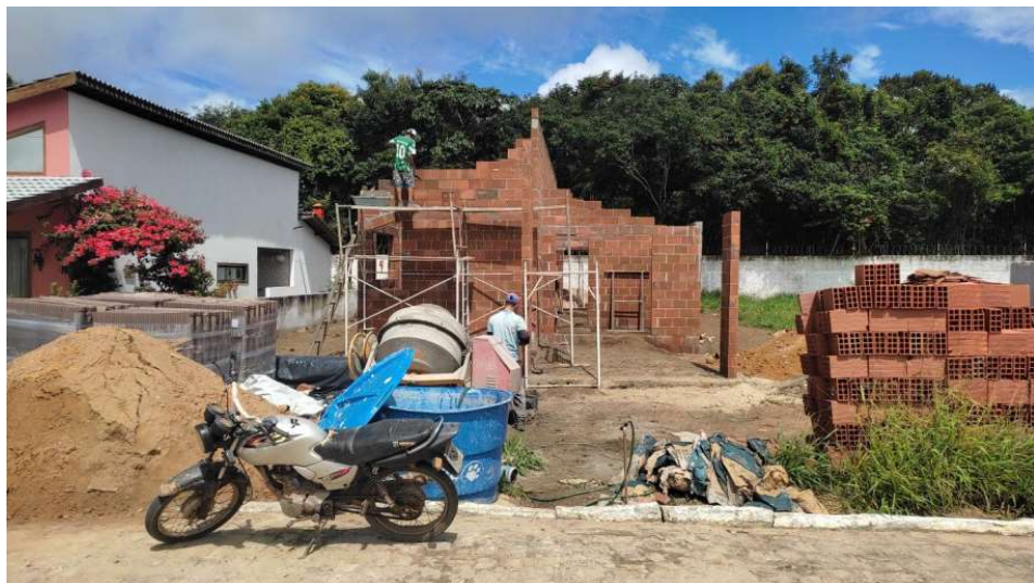
Foto 04 - Obra na cidade de BANANEIRAS
